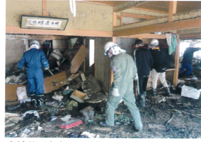
宮城県石巻市にて被災家屋の片付け作業
